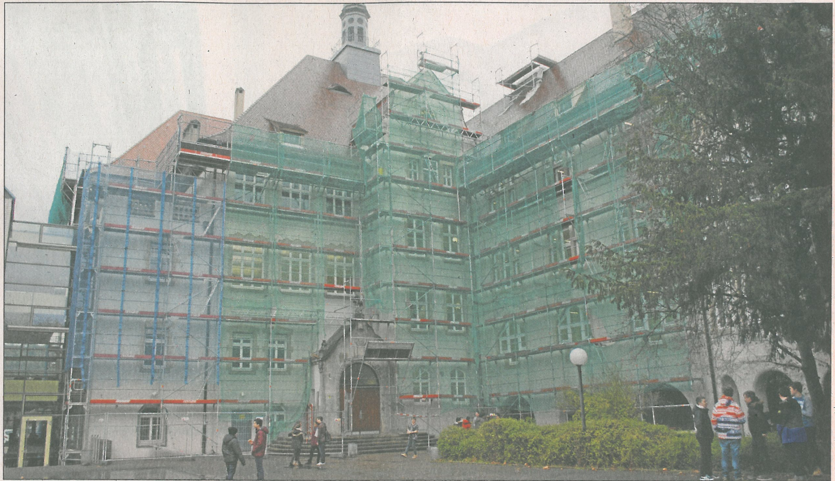
Endspurt im Lindenschulzentrum: Bis März sollen die Dacherneuerung und die Sanierung der Entlüftungshauben beendet sein. Foto: Kuhn
